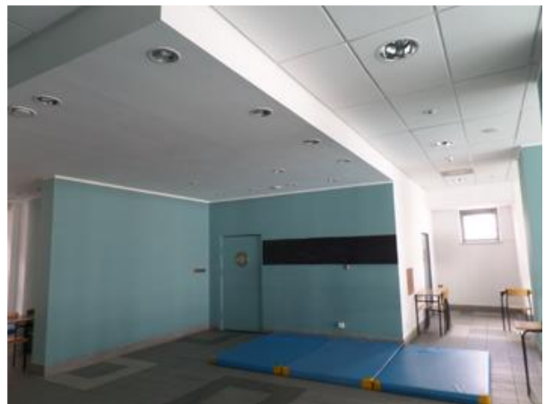
Pomieszczenie wejściowe 1 ujęcie.f
