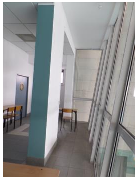
Pomieszczenie wejściowe 1 ujęcie.h
