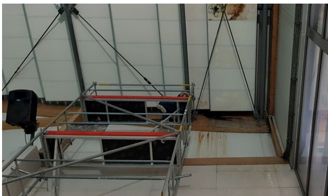
zacieki widoczne na więzarach dachowych i panelach sufitu podwieszanego spowodowane nieszczelnością połaci dachu i wkraplaniem się pary wodnej na wewnętrznych częściach instalacji kanalizacyjnej deszczowej
