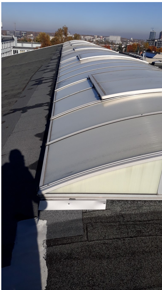
nie działające klapy naświetli poliwęglanowych
