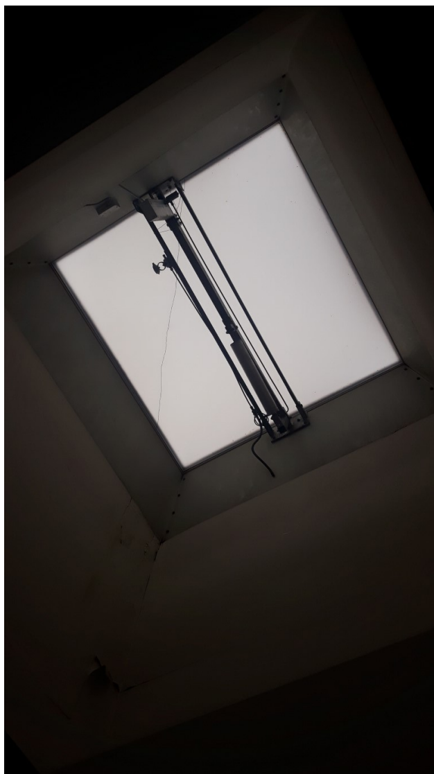
brak naboju CO2 w klapach systemu oddymiania i uszkodzone siłowniki elektryczne
