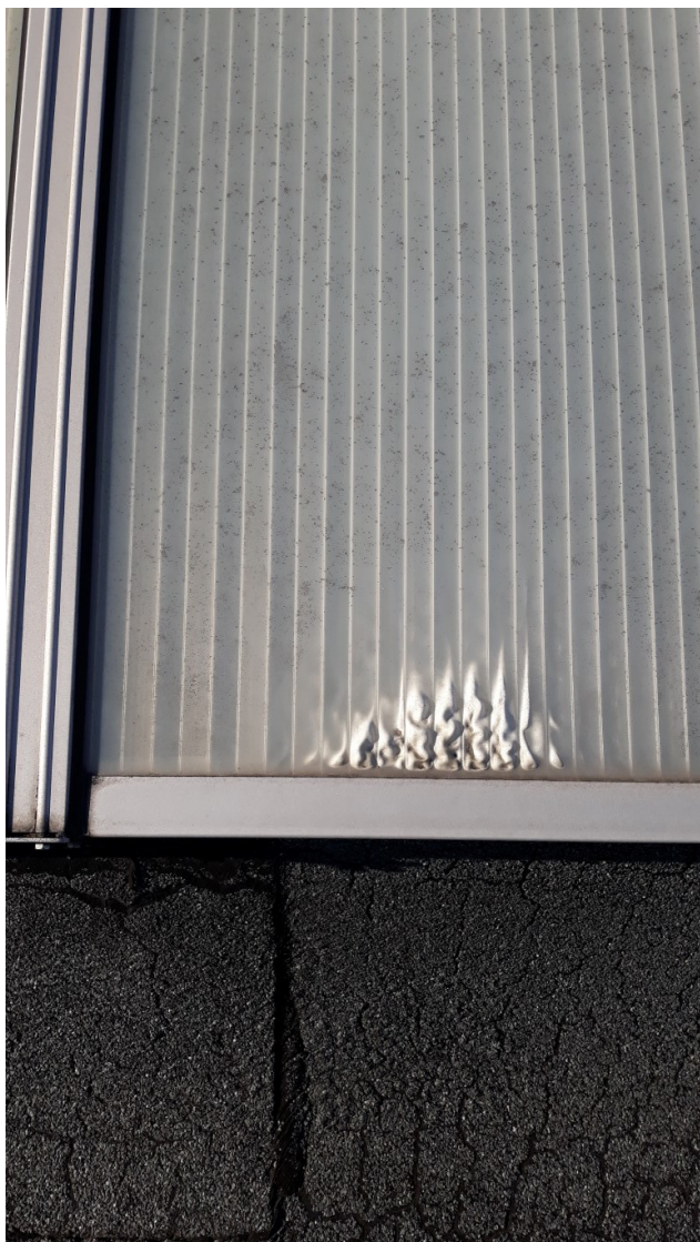
nadpalone elementy poliwęglanu w nasświetlach
