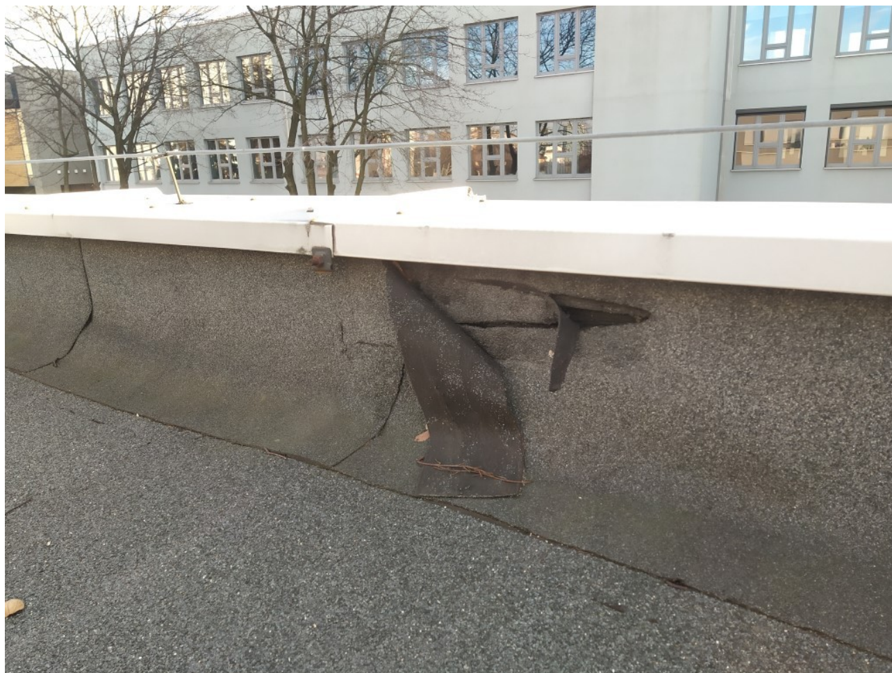
Uszkodzenia i nieuszczelności pokrycia dachu
