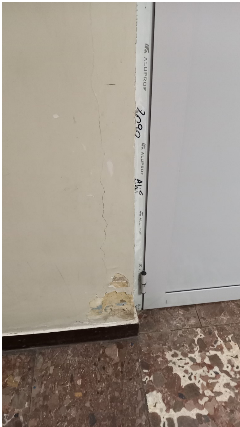
Zawilgocenia ścian wewnętrznych przyziemia
