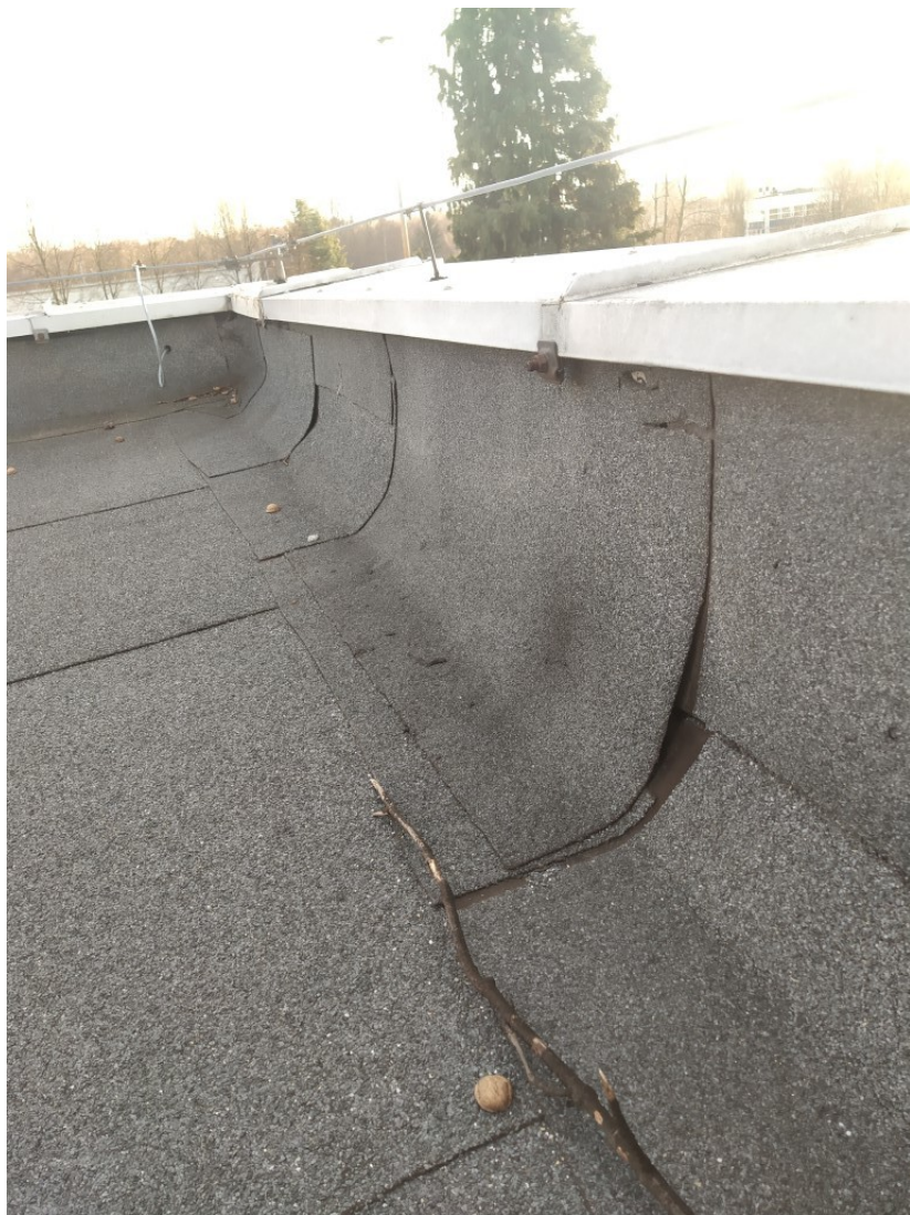
Uszkodzenia i nieszczelności pokrycia dachu
