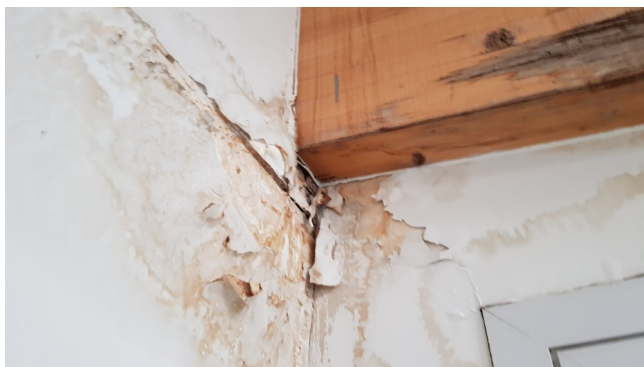
zacieki spowodowane nieszczelnością połaci dachu
