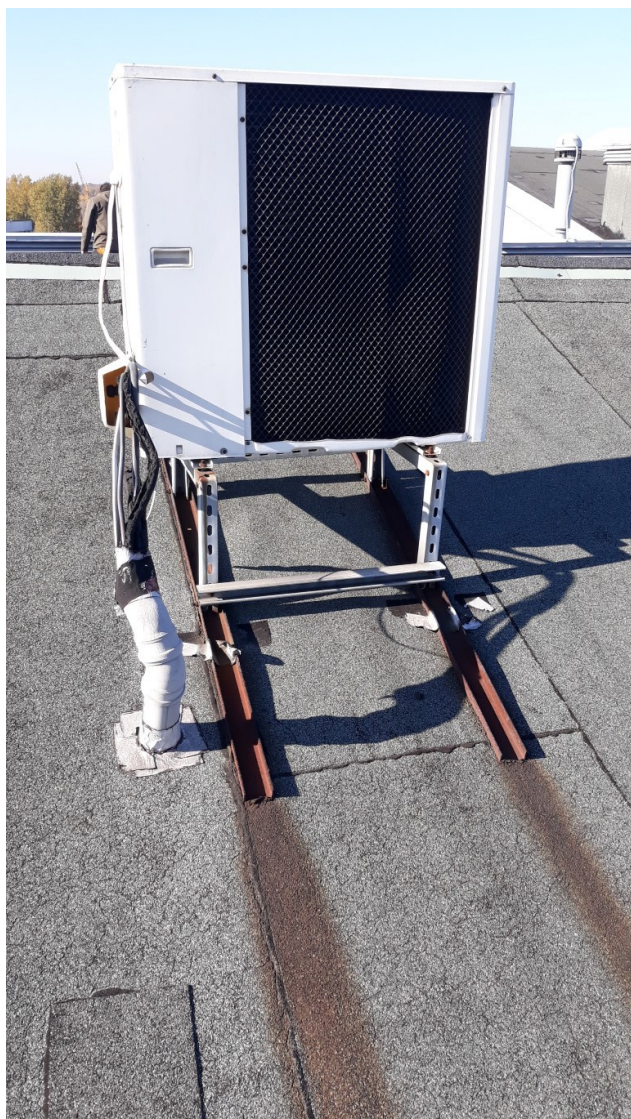
nieodpowiednie podstawy dachowe pod urządzenia
