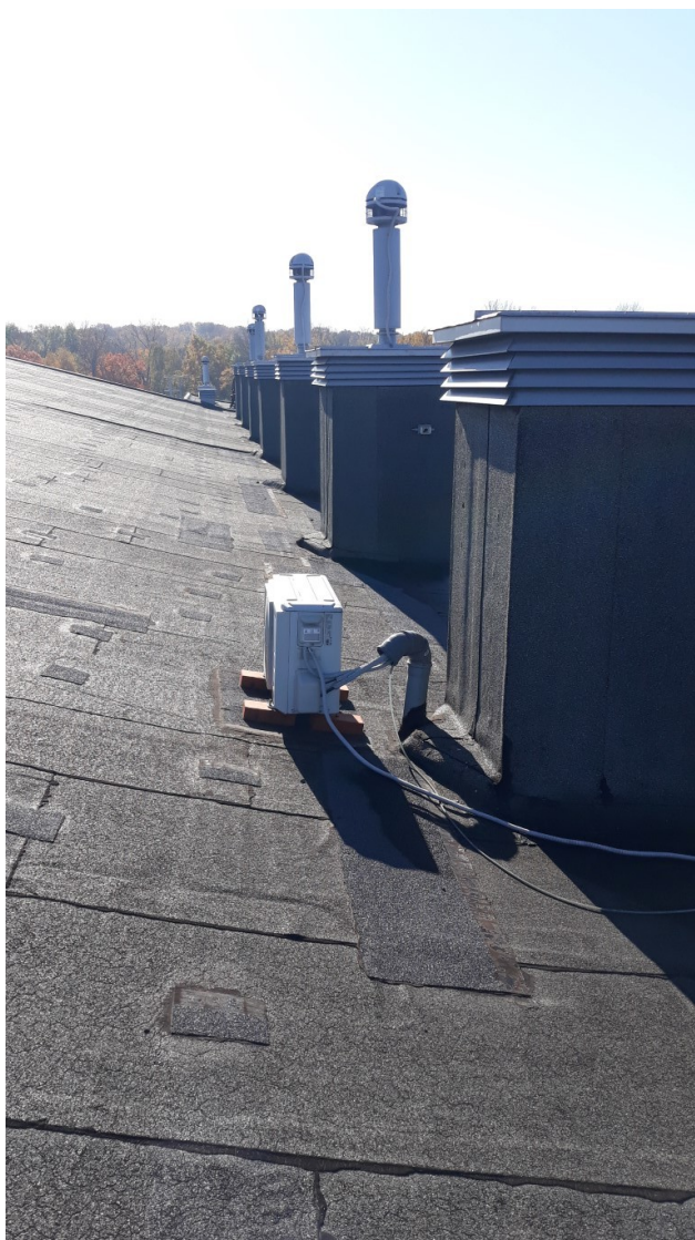
nieodpowiednie podstawy dachowe pod urządzenia i błędnie wykonane przejście na instalację wykonane kielichem do góry
