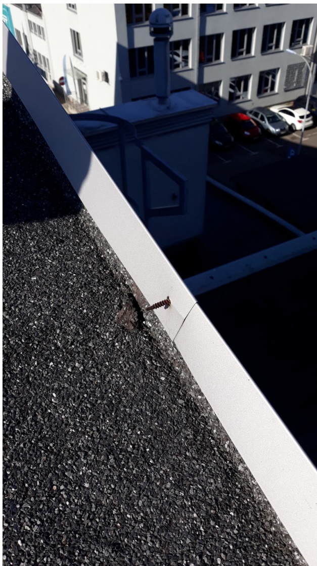
montaż opierzeń za pomocą śrub typu farmer
