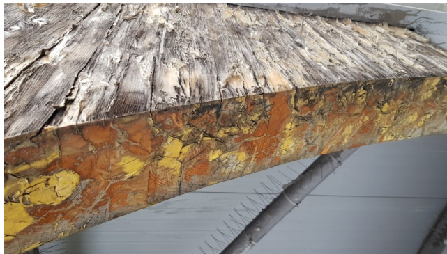
powierzchniowo zniszczona zewnętrzna część więzara
