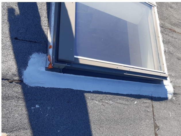
próby uszczelnienia okien połaciowych
