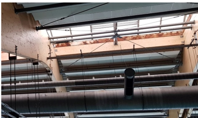
korozja biologiczna podstaw naświetli poliwęglanowych
