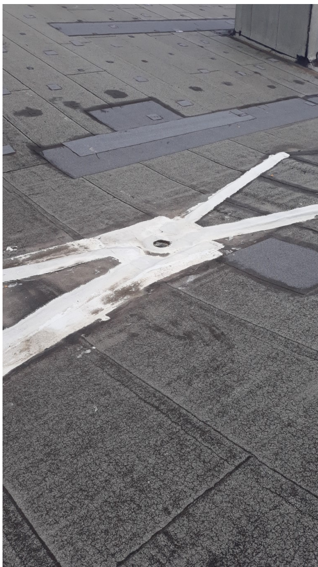
próba naprawy połączeń za pomocą natrysku powłoką poliuretanową i wpusty kanalizacji deszczowej bez koszy ochronnych
