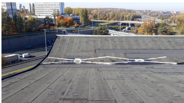
połatana i uszczelniana połąć dachu
