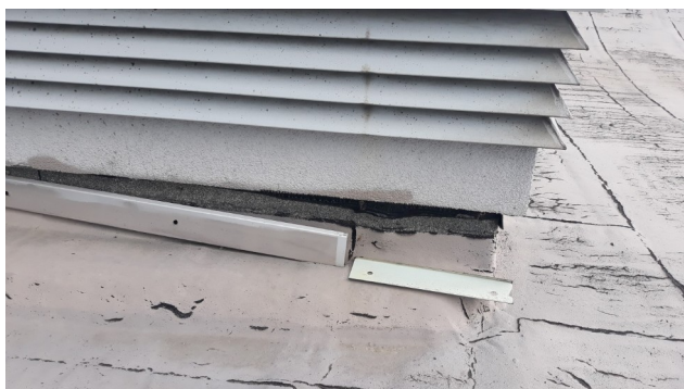
zdemontowane obróbki dekarne wokół kominów
