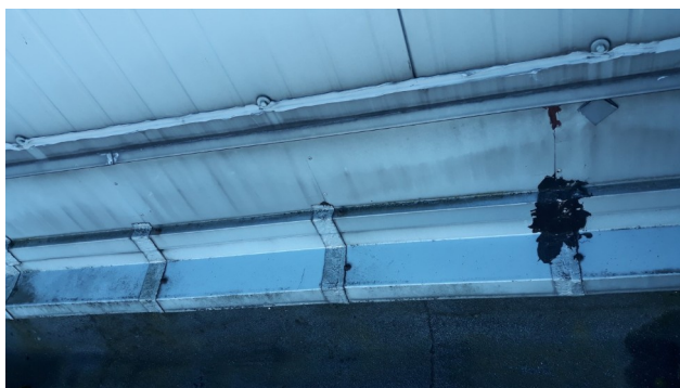
próby naprawy nieszczelności opierzeń taśmą bitumiczną
