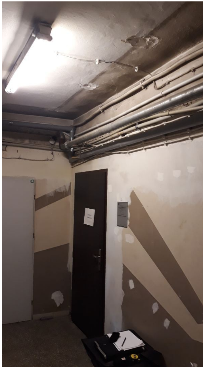
Instalacje na ścianie pomieszczeń do zabudowy GK
